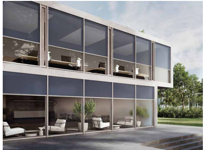
Pfosten-Riegelkonstruktion mit außenliegendem SUN-TEX als Sonnenschutz
