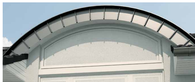
Beispiel: Spannrahmen als Sonderform mit SUN-TEX fest montiert, als sommerlicher Wärmeschutz
